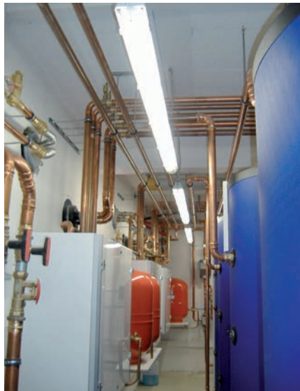
Für die meisten Trinkwasser-Großanlagen besteht künftig nur noch eine dreijährige Untersuchungspflicht.
